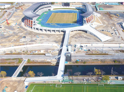
HATOスタジアム(上)から金亀公園への「城北百間橋」
